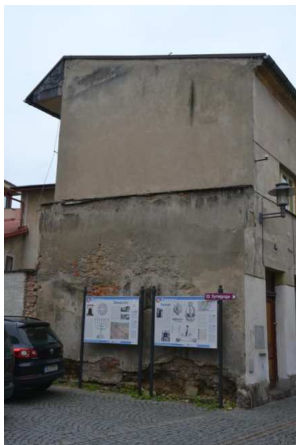
Dům č. p. 482, severovýchodní štítové průčelí, foto IP 2014.
