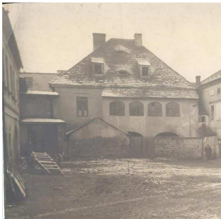
Dům č. p. 2219 (zcela vlevo hrana snímku) patrná fasáda domu v první polovině 20. století, (foto sbírka MČR, inv. č. AFT 703 a).
