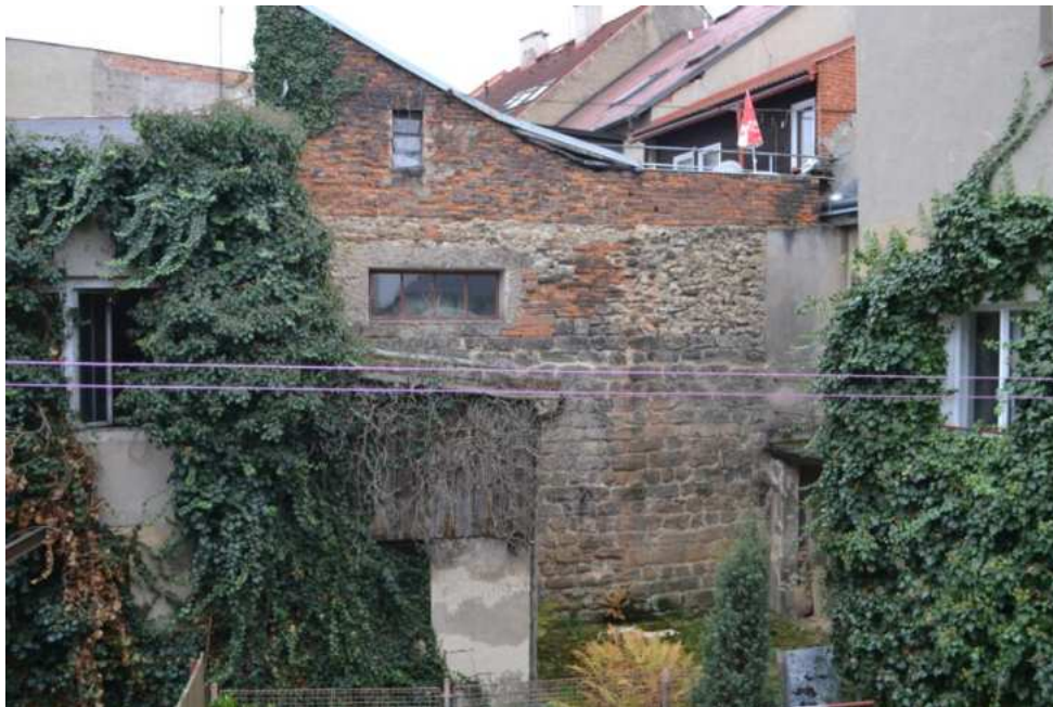
Dům č. p. 475, západní zeď oddělující dvory č. p. 475 a 476, za ní přístavby domu č. p. 475, foto MK 2015.
