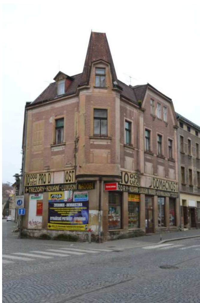
Dům č. p. 749, západní nároží a jižní průčelí domu, foto IP 2014.
