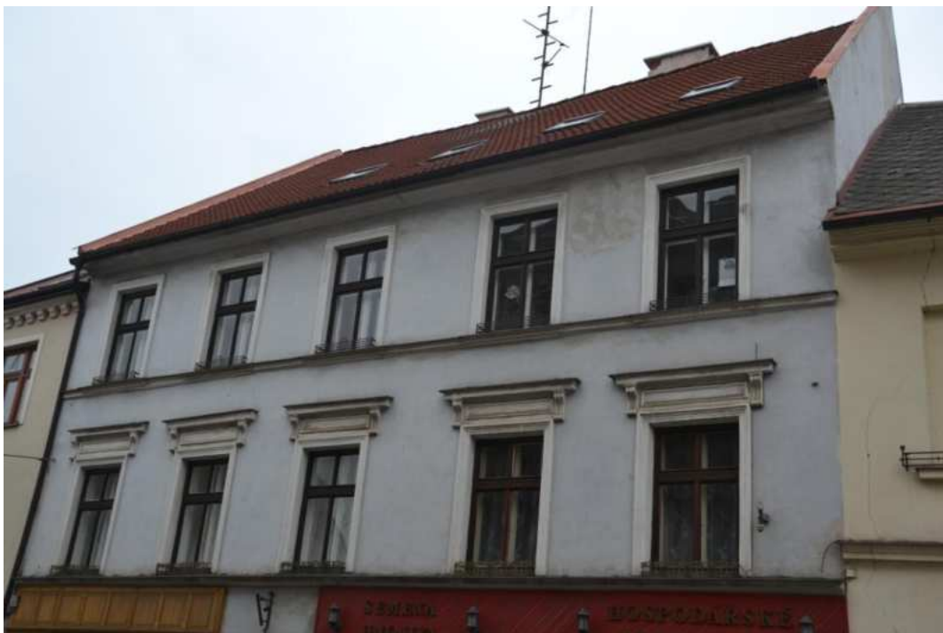
Dům č. p. 473, hlavní jižní průčelí – detail horních podlaží, foto IP 2014.
