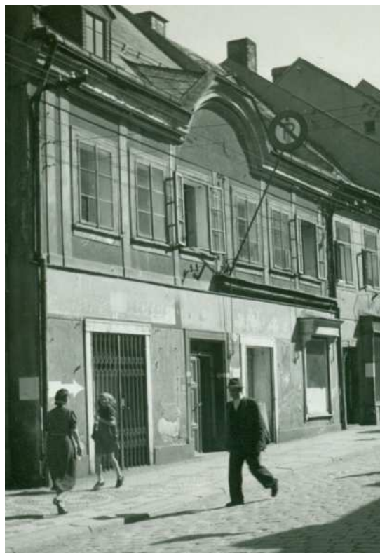
Dům č. p. 477 v roce 1944, (foto sbírka MČR, inv. č. AFT 583).
