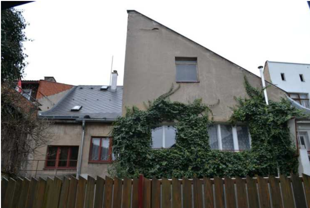
Dům č. p. 476, dvorní severní průčelí (vlevo), foto MK 2016.
