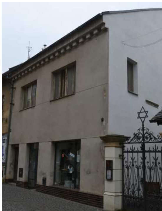
Dům č. p. 480, hlavní severozápadní průčelí, foto IP 2014.
