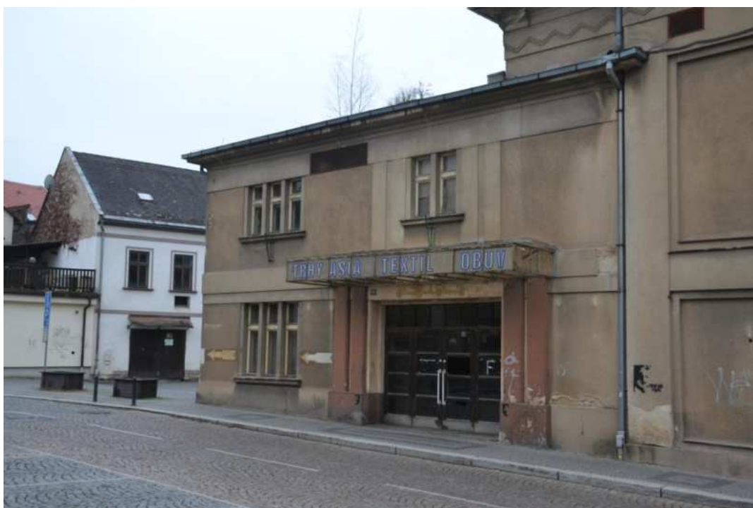
Dům č. p. 488, východní průčelí, foto IP 2014.
