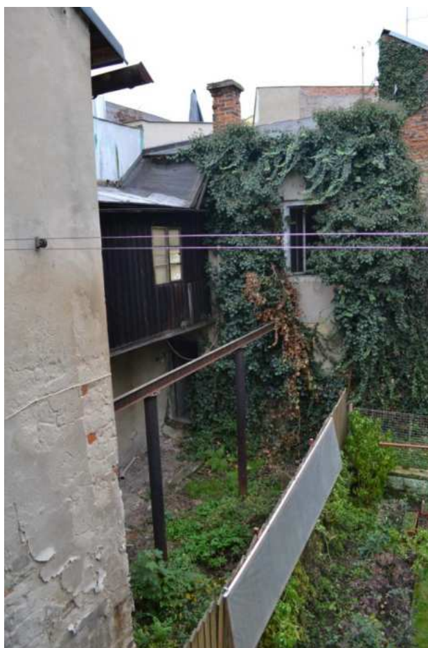
Dům č. p. 480, pohled od domu na dvorní doplňkovou stavbu a spojovací pavlač, foto MK 2015.
