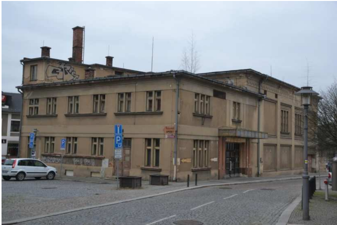
Dům č. p. 488, celkový pohled od jihu, foto IP 2014.
