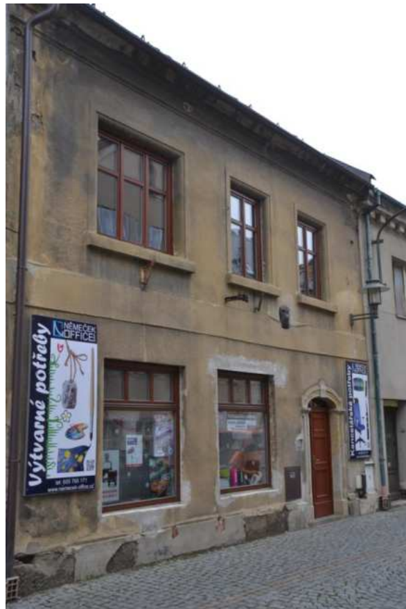
Dům č. p. 181, hlavní severozápadní průčelí, foto IP 2014.
