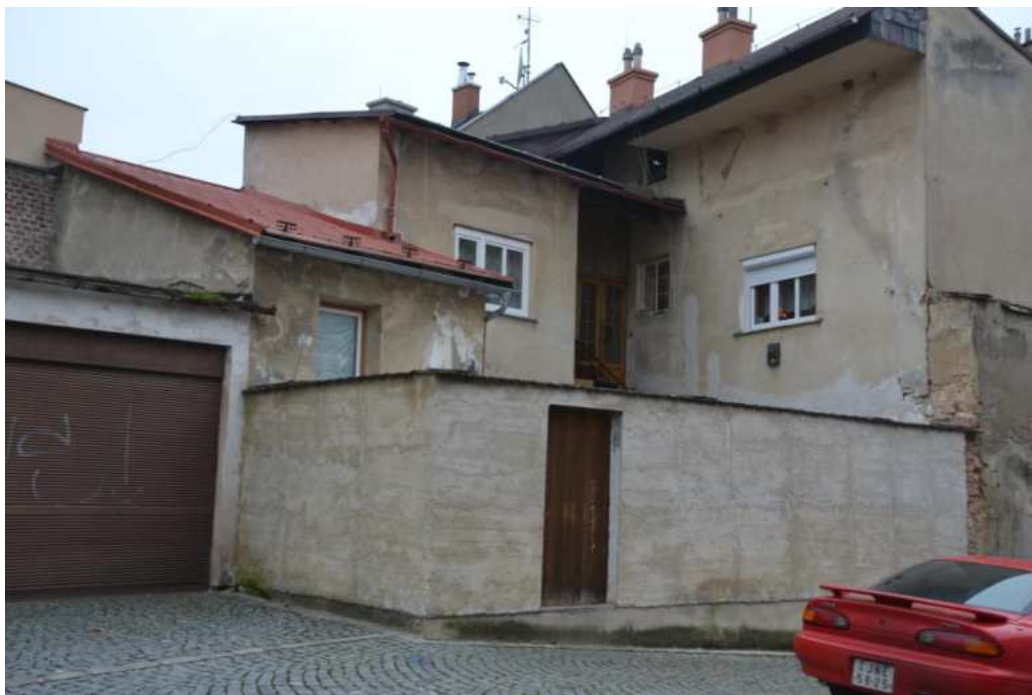
Dům č. p. 482, dvorek, garáž a přístavby u severovýchodního zadního průčelí, foto IP 2014.
