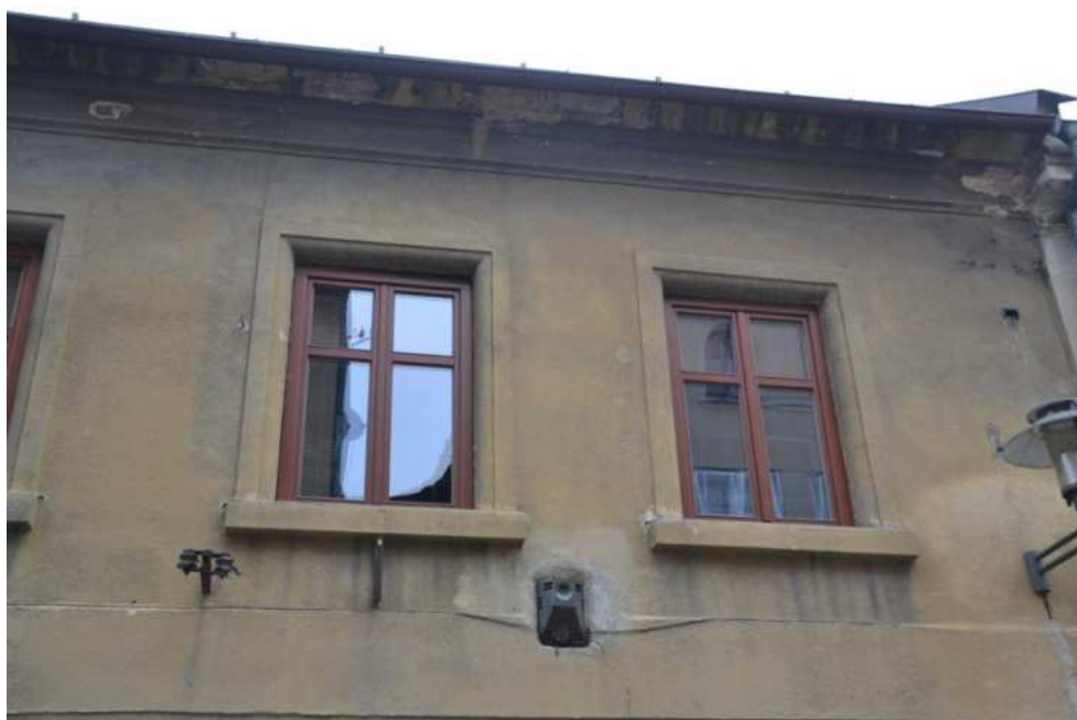
Dům č. p. 181, hlavní severozápadní průčelí, detail oken patra, foto IP 2014.
