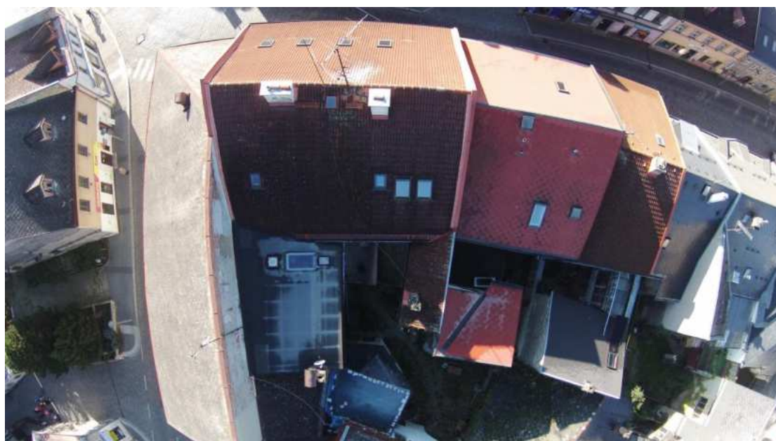
Dům č. p. 472 ve výřezu leteckého snímku (vlevo), foto A. Kopecký 2014.
