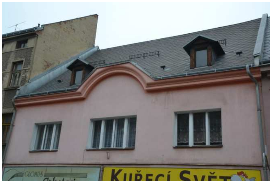
Dům č. p. 477, hlavní jižní průčelí, detail patra a střechy, foto IP 2014.
