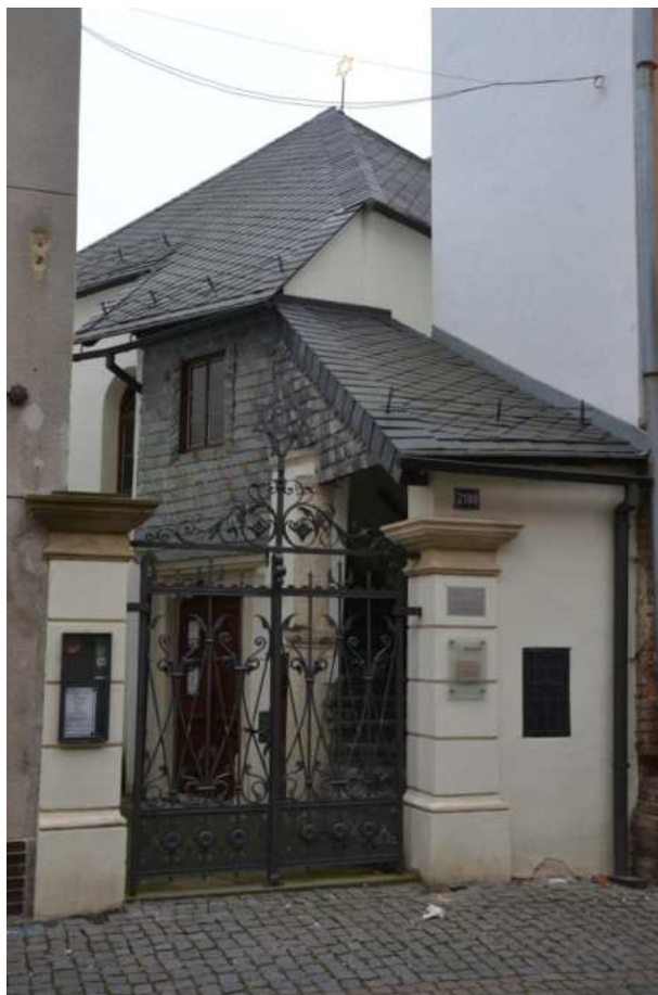
Dům č. p. 2219, vstup do synagogy z Krajířovy ulice, foto IP 2014.
