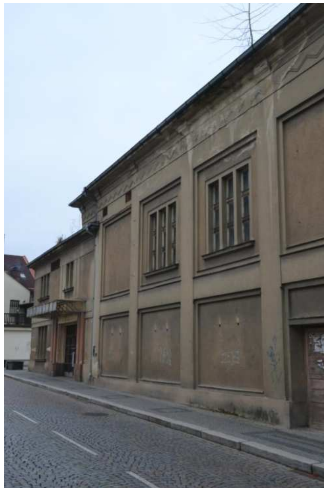
Dům č. p. 488, východní průčelí, foto IP 2014.
