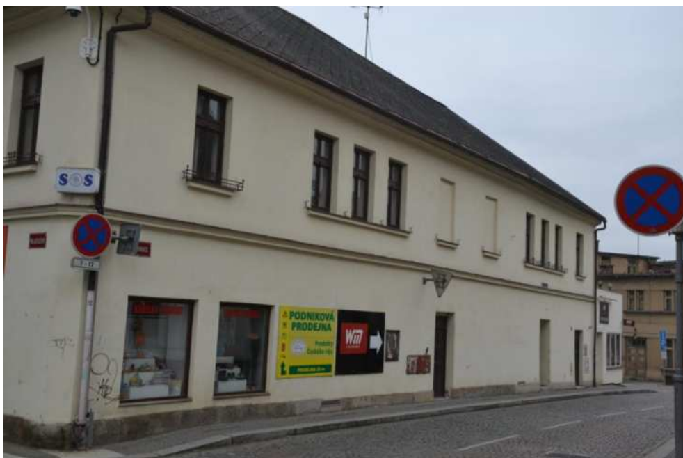
Dům č. p. 472, boční východní průčelí, foto IP 2014.
