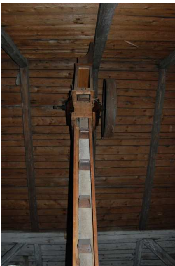
Dům č. p. 2219, interiér mladšího krovu, patrně po roce 1904, detail korečkového dopravníku, foto IP 2010.
