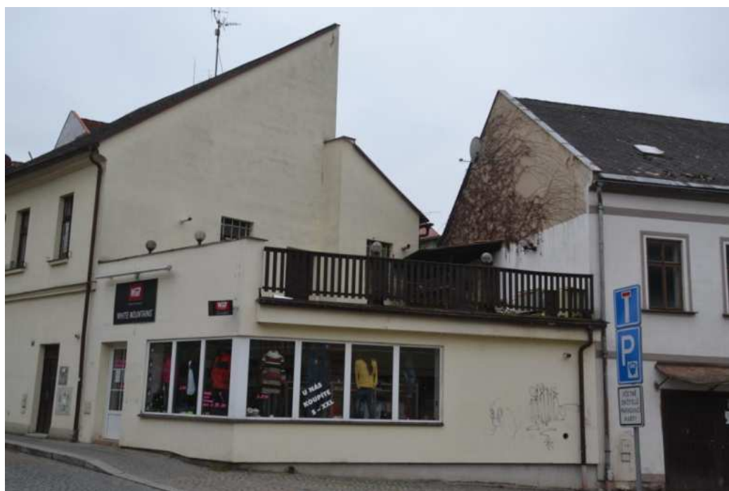
Dům č. p. 472, severní štítové průčelí a novodobá přístavba prodejny, foto IP 2014.
