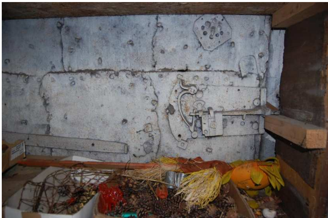
Dům č. p. 2219, levý trakt, zámek a rubová strana dveří do mladší pražírny kávy, foto IP 2010.
