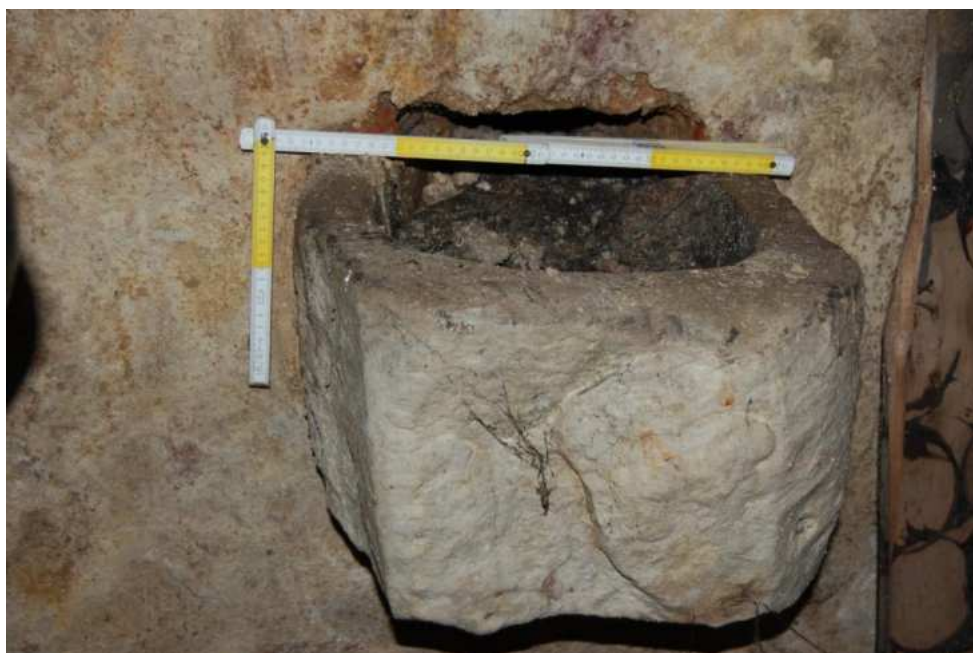
Dům č. p. 473, detail pískovcové výlevky v jižním klenebním čele, foto IP 2011.
