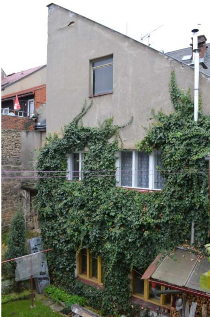
Dům č. p. 477, dvorní severní průčelí, foto MK 2016.
