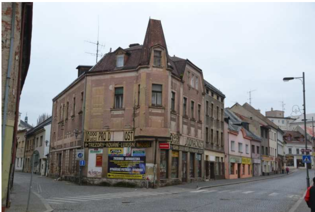
Dům č. p. 479, celkový pohled od západu, foto IP 2014.
