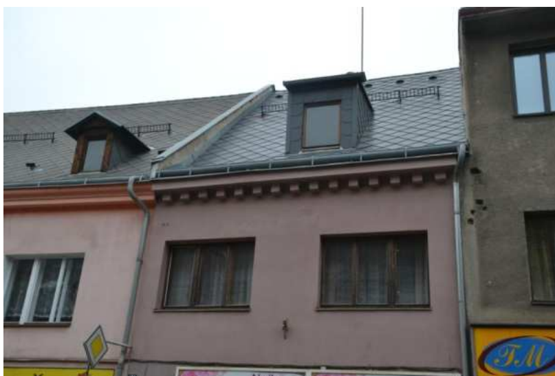
Dům č. p. 476, hlavní jižní průčelí, detail patra a střechy, foto IP 2014.
