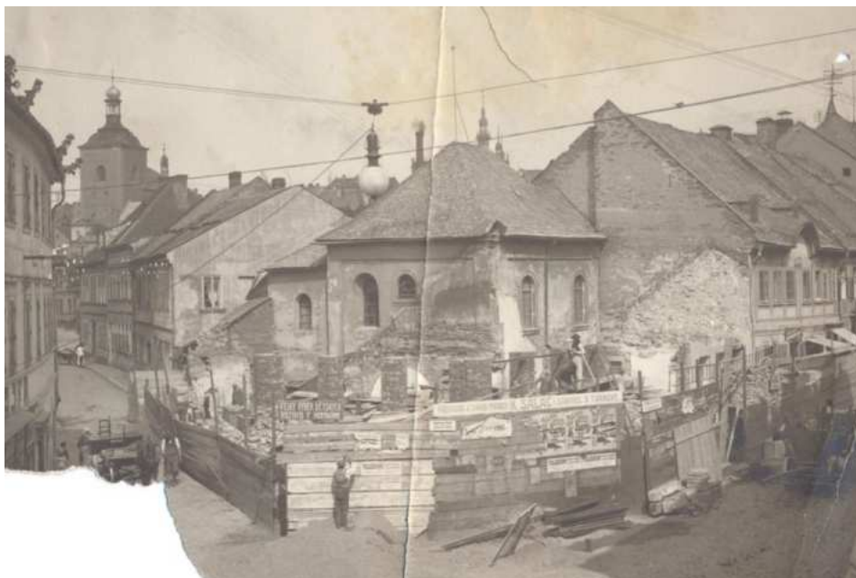
Výstavba nových domů č. p. 478 a 479 kolem roku 1909, (foto sbírka MČR, inv. č. AFT 1072 a).
