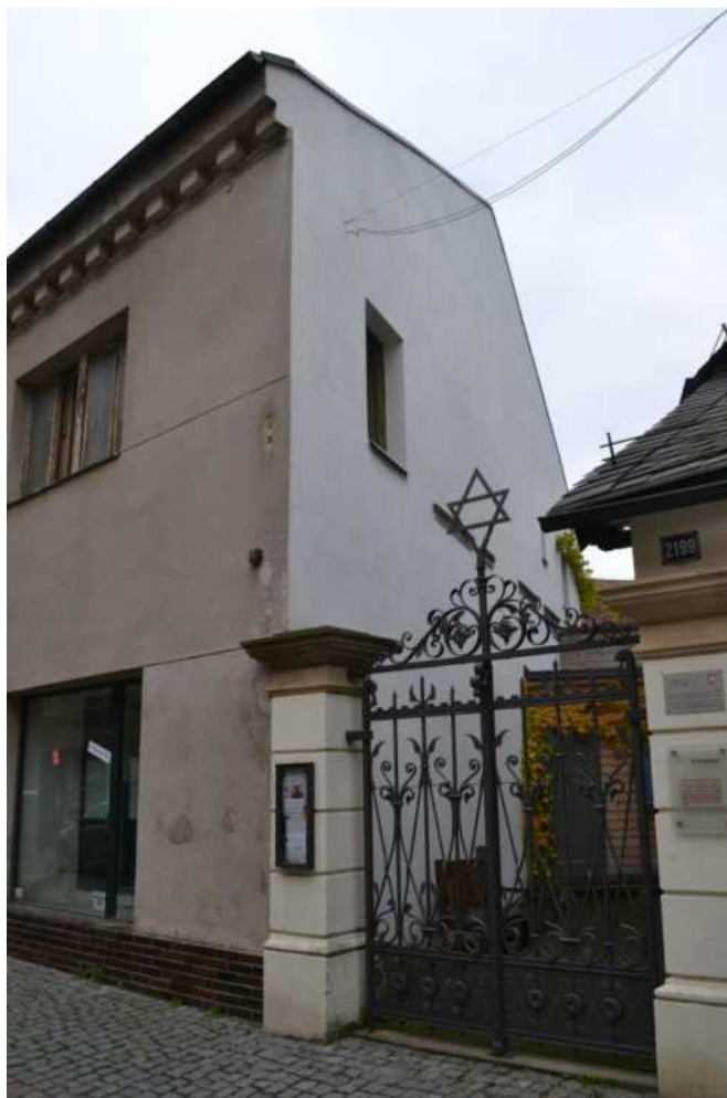
Dům č. p. 480, boční jihozápadní průčelí, foto MK 2015.
