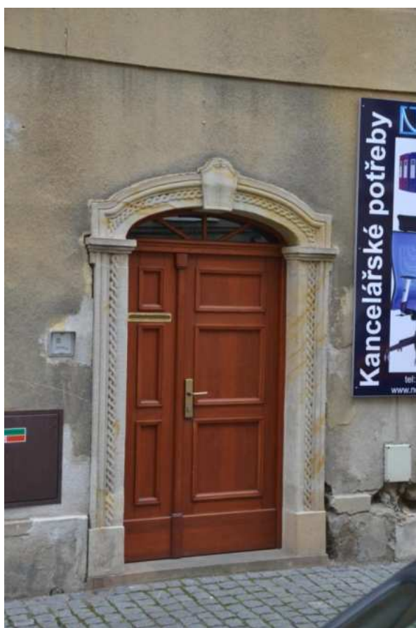
Dům č. p. 481, hlavní severozápadní průčelí, detail portálu, foto IP 2014.
