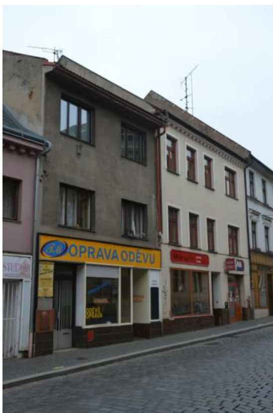
Dům č. p. 475, hlavní jižní průčelí a část štítu, foto IP 2014.
