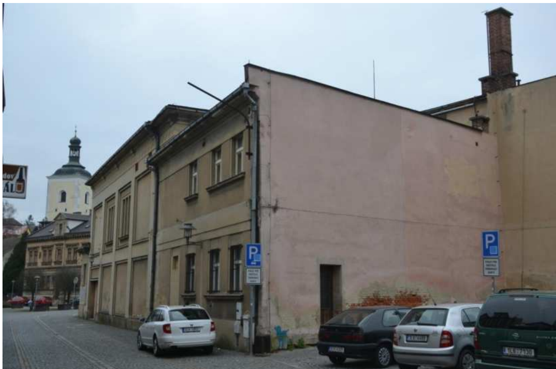
Dům č. p. 488, část jihozápadního průčelí a severozápadní průčelí, foto IP 2014.
