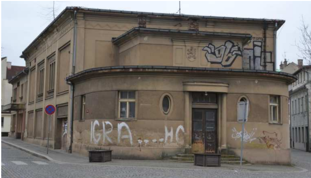
Dům č. p. 488, severovýchodní průčelí, foto IP 2014.
