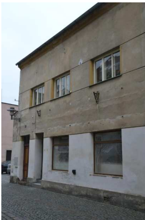
Dům č. p. 482, hlavní severozápadní průčelí, foto IP 2014.
