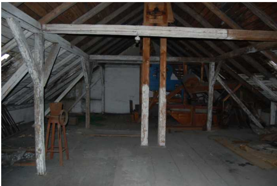
Dům č. p. 2219, interiér mladšího krovu, patrně po roce 1904, foto IP 2010.
