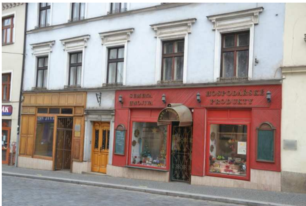
Dům č. p. 473, hlavní jižní průčelí – detail přízemí, foto IP 2014.
