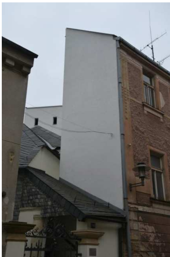
Dům č. p. 479, štít a část severozápadního průčelí kryjící budovu synagogy, foto IP 2014.
