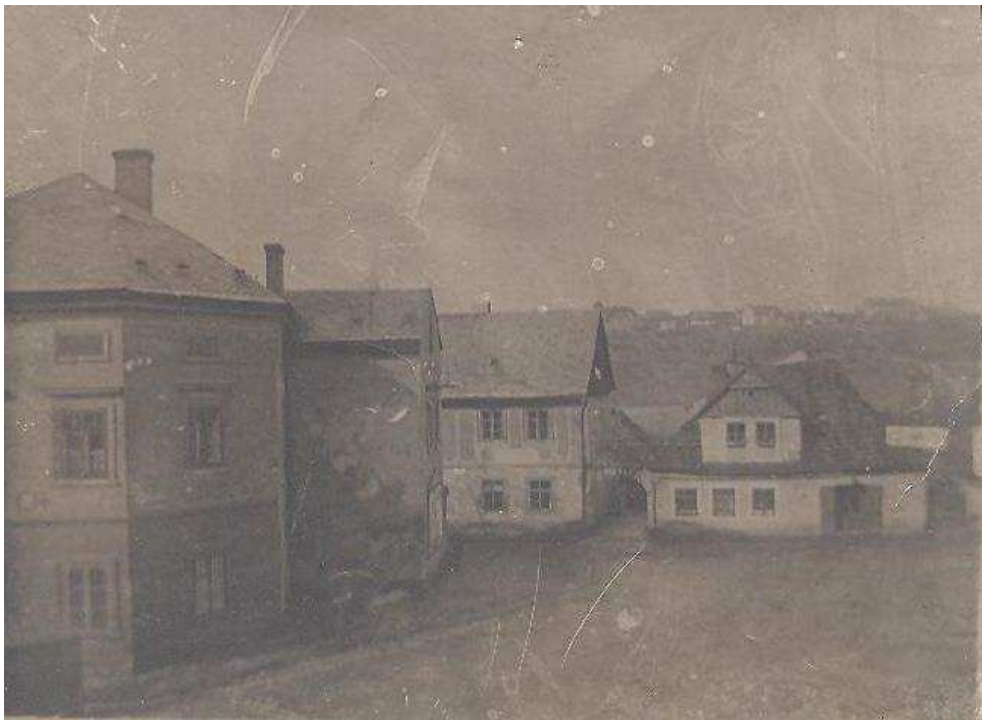
Dům č. p. 488 (zcela vlevo) mezi lety 1914 a 1926, (foto sbírka MČR, inv. č. AFT 703 b).
