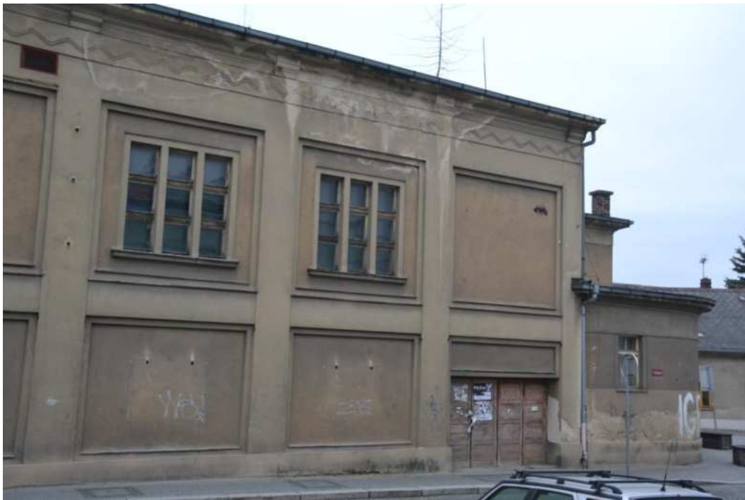
Dům č. p. 488, východní průčelí, foto IP 2014.
