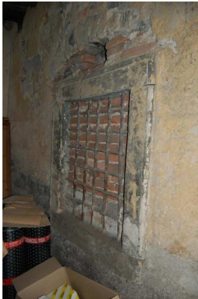
Dům č. p. 2219, zadní jihozápadní část domu, barokní okno zakryté mladší přístavbou, foto IP 2010.
