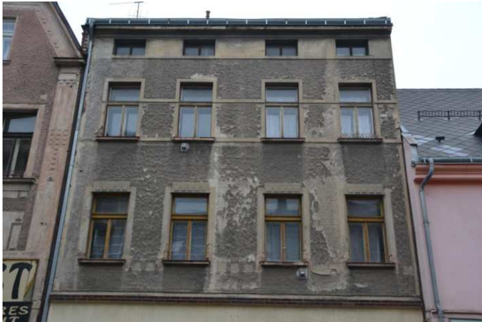
Dům č. p. 478, hlavní jižní průčelí, detail horních podlaží, foto IP 2014.
