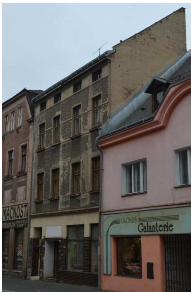
Dům č. p. 478, celkový pohled na jižní hlavní průčelí, foto IP 2014.
